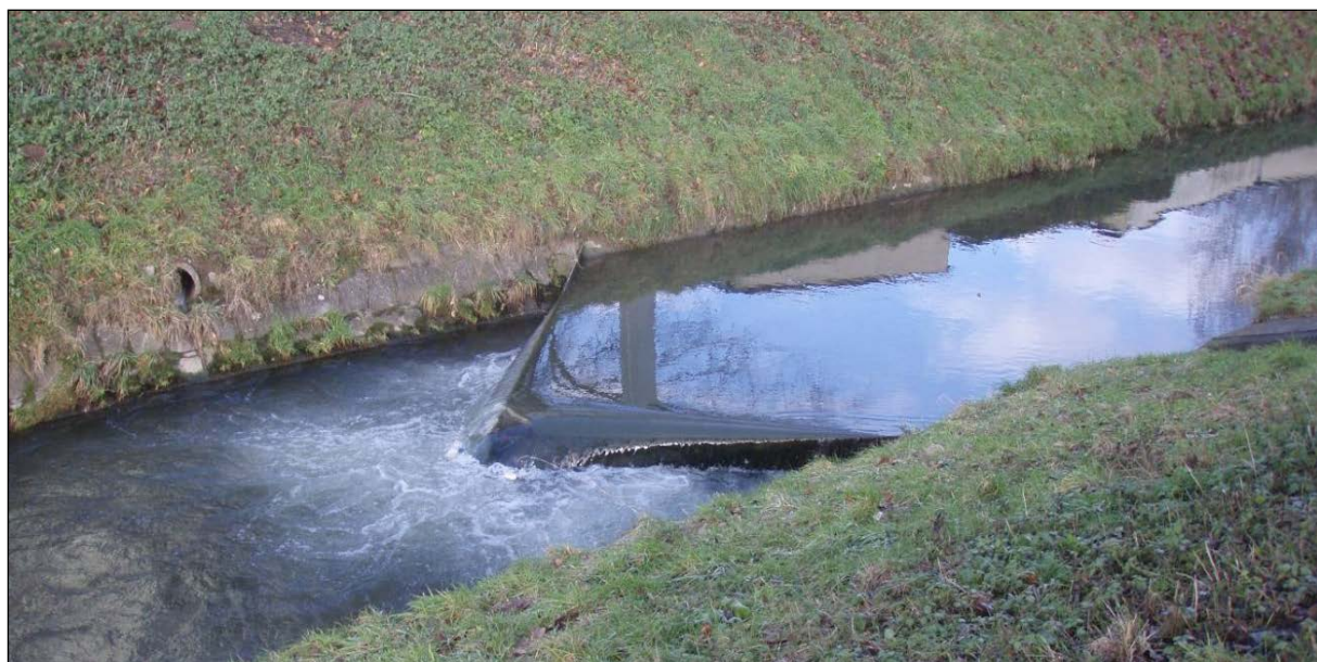
Abb. 5: Pegelanlage am Leimbach, oberhalb der Alten Heerstraße
